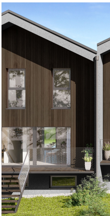
Garde-corps en base
